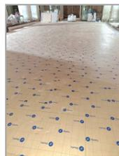
Dans la nef, les ouvriers sont en train de mettre en place le réseau du chauffage par le sol (cf. photo à gauche).
