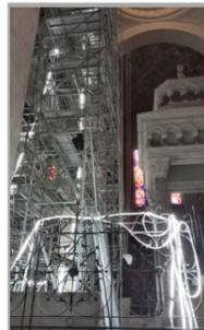
Comme le montre la photo, un échafaudage a été installé à l'arrière du ciborium, en vue de la reprise de l'arc central (celui qui a dû être sécurisé avec le grand étai en acier au dessus du chœur).
